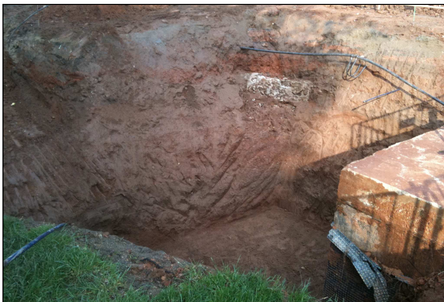
Fig. 1.- Foto final de la intervenció a la zona del dipòsit.
