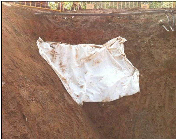
Fig. 22. Vista del mur u.e.07 a la zona del dipòsit tapat amb geotèxtil.
