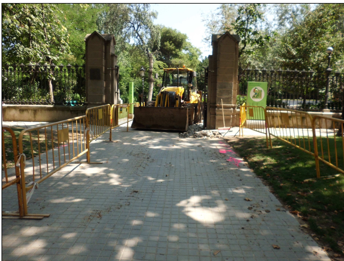
Fig. 18. Vista de la zona on es realitzarà la Rasa 1 a la zona del carrer de Pujades (fora del Parc)
