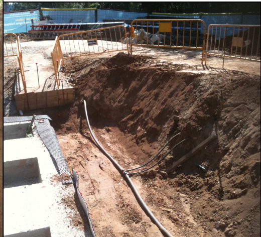
Fig.23. Vista de la zona del mur un cop cobert.
