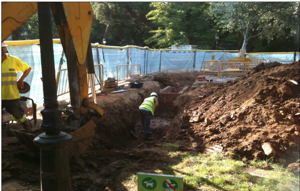
Fig. 14. Vista dels treballs de rebaix de la u.e.04
