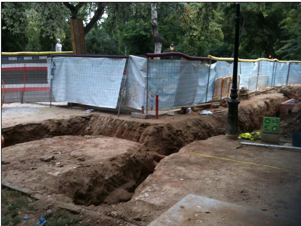
Fig. 19. Vista de la Rasa 1, amb les rases 1a i 1b durant els treballs de rebaix
