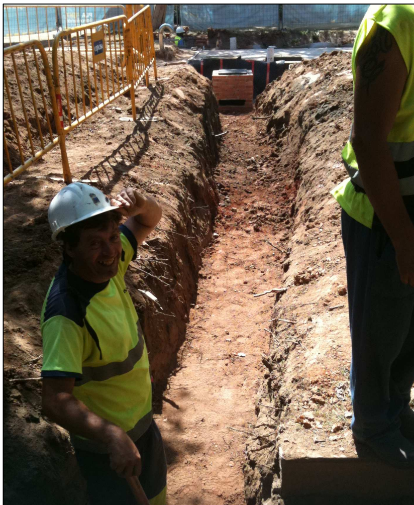
Fig. 20. Vista del tram inicial de la Rasa 2x
