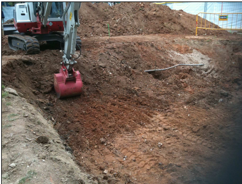
Fig. 11. Vista dels treballs de rebaix de la u.e.02
